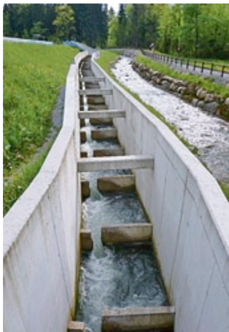
Fischtreppe helfen, Barrieren zu überwinden. EAWAG
